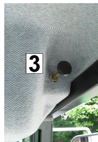
regulace teplého vzduchu
